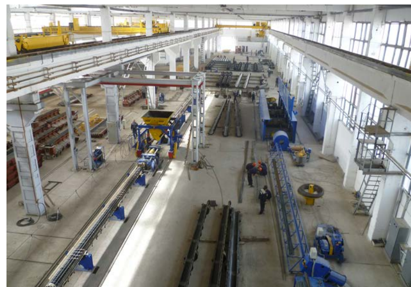
Реконструированный цех по производству опор контактной сети железной дороги
