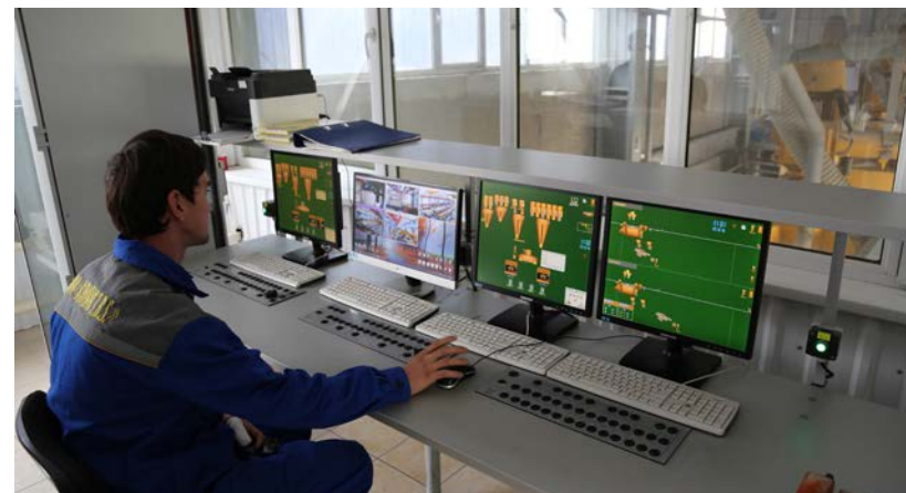
Операторская БСУ после реконструкции
