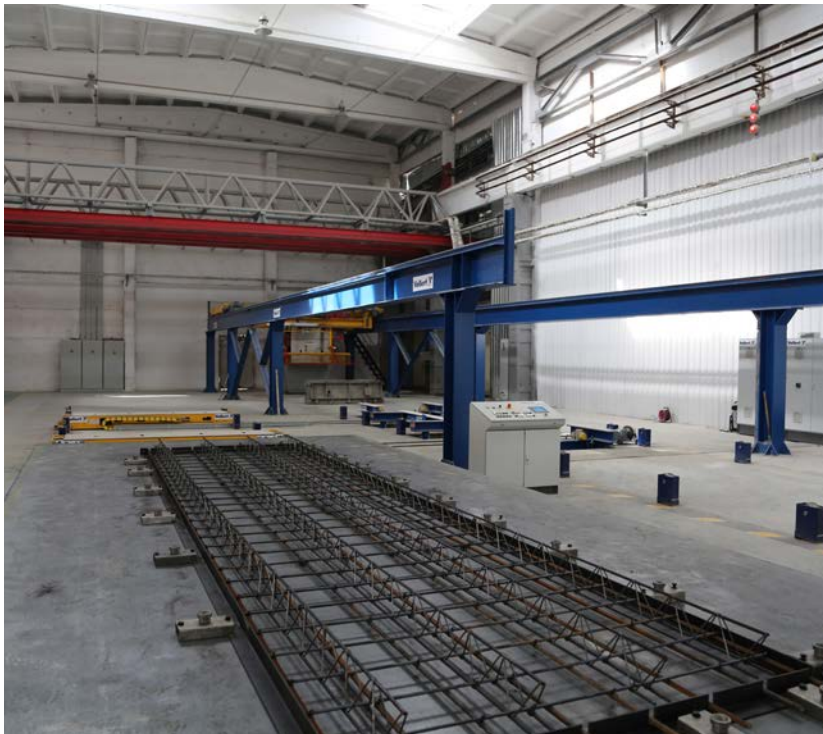
Пост армирования циркуляционной линии
