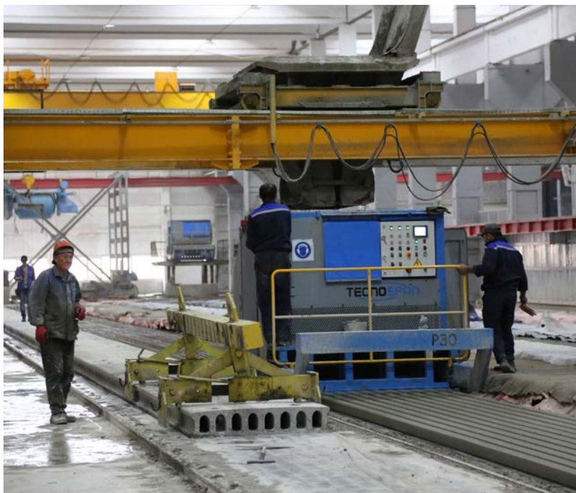
Процесс формирования шпалер. Слева на дорожке – готовая многупустотная плита
