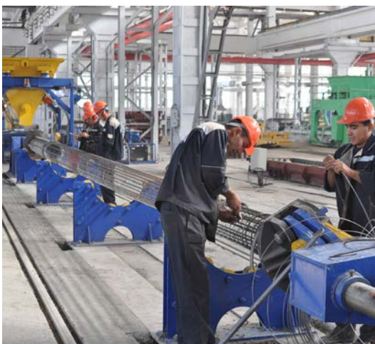
Установка каркаса для производства опоры контактной сети железной дороги
